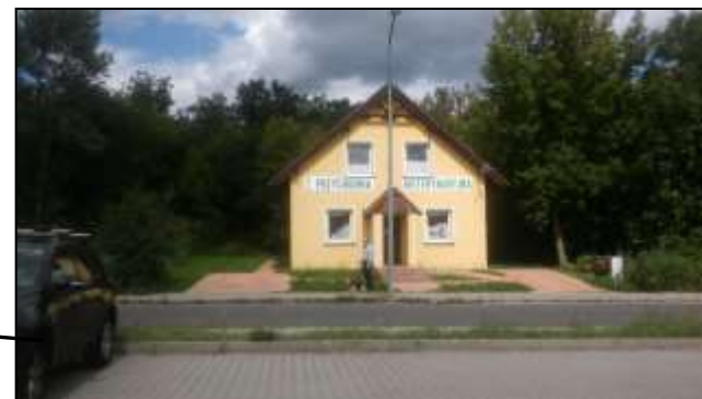
Budynek mieszkalno-usługowy ul. Mołdawska 1
