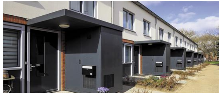
Fot. 1. Moduły energetyczne w trakcie montażu; Fot. Nathan Group
